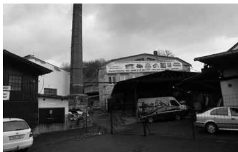
Bývalý horní mlýn na Bukově (foto V. Horák, 2016)
